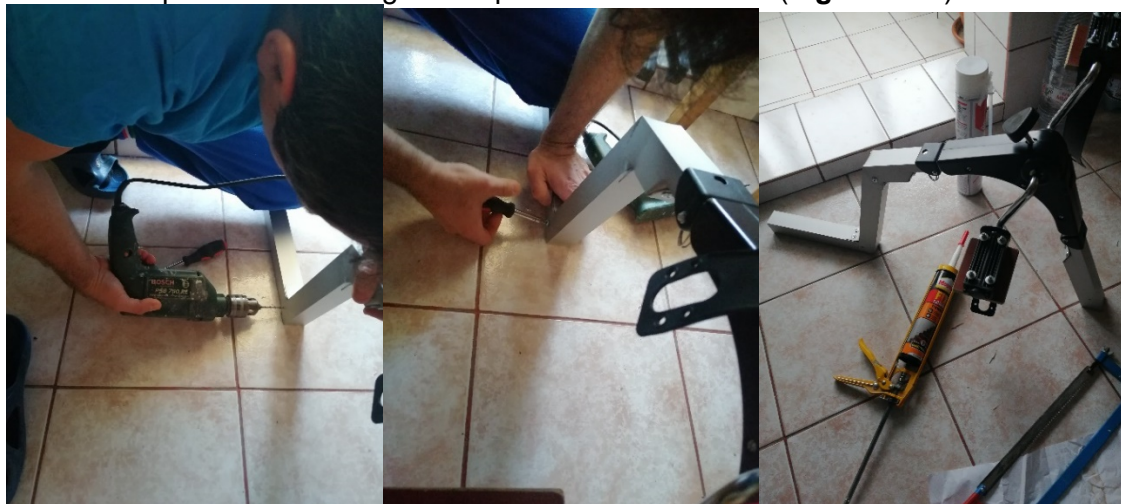
Figura 7.18 Fixarea unghiurilor profilului de aluminiu cu ajutorul șuruburilor autofiletante pentru tablă [contribuție proprie]
